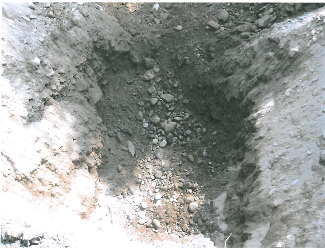
Il fondo scavo profondo 7 mt dal piano campagna in cui sono state eseguite le prove in sito.
