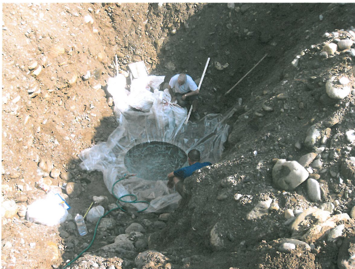
Le varie fasi di riempimento del pozzetto con acqua potabile.
