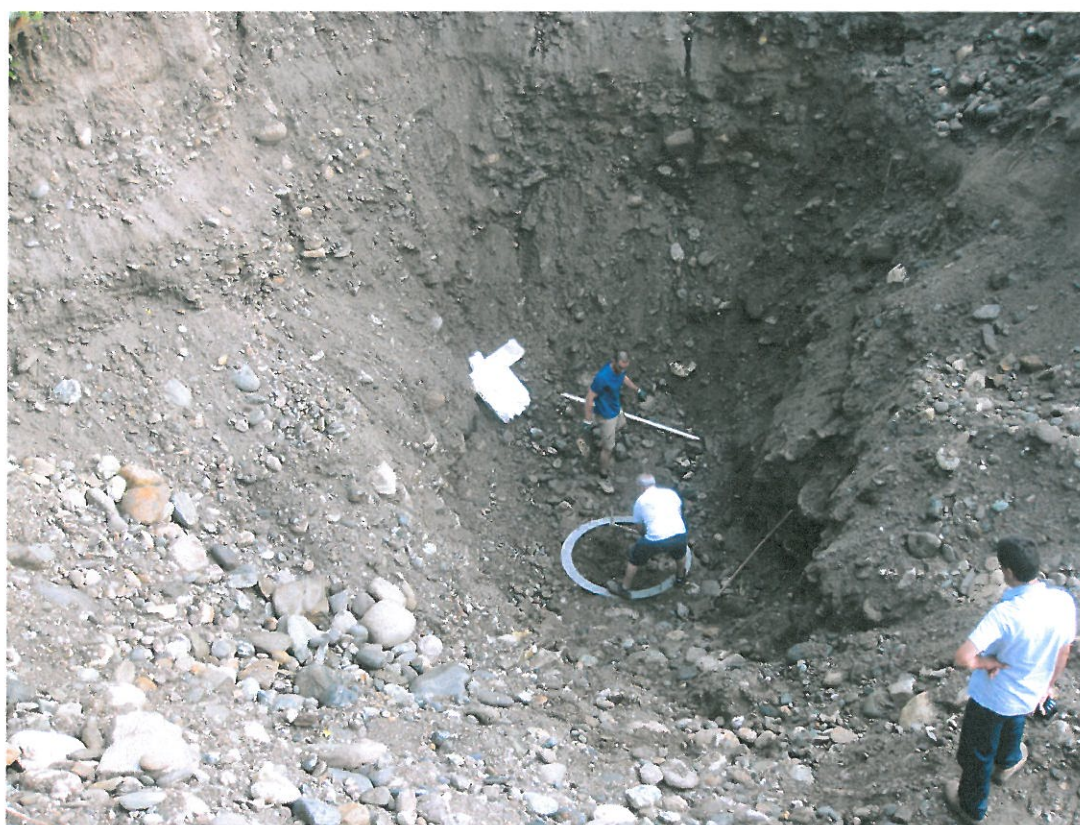
La posa della dima circolare di 120 cm di diametro. Da notare la presenza di consistenti e numerosi ciottoli di varie dimensioni.
