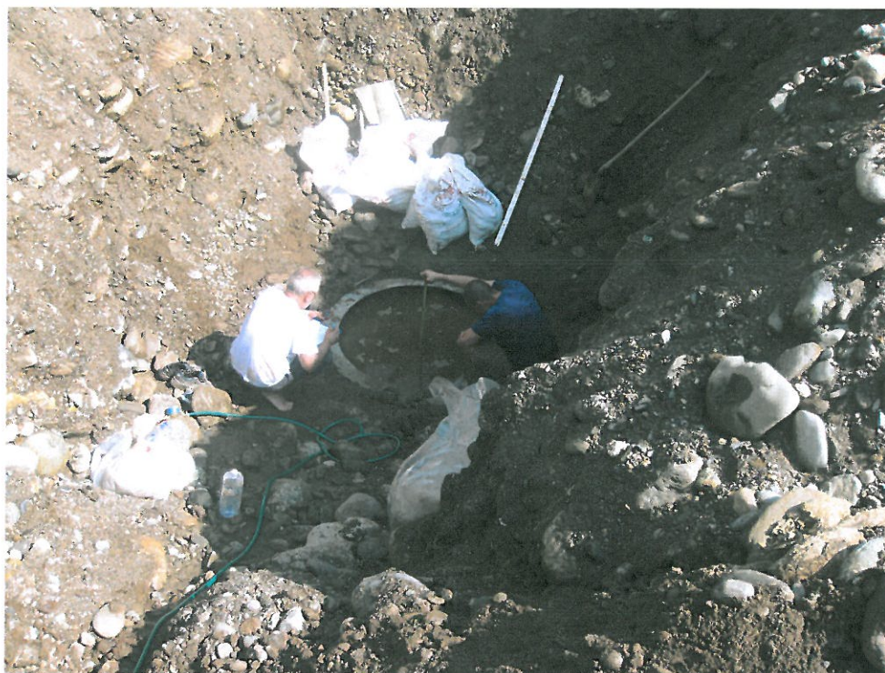
Le fasi di misurazione della volontà di deflusso dell'acqua dal pozzetto.
