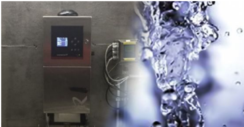
Sistema di monitoraggio della qualità dell'acqua (© ACEA Pinerolese Industriale S.p.A.)
