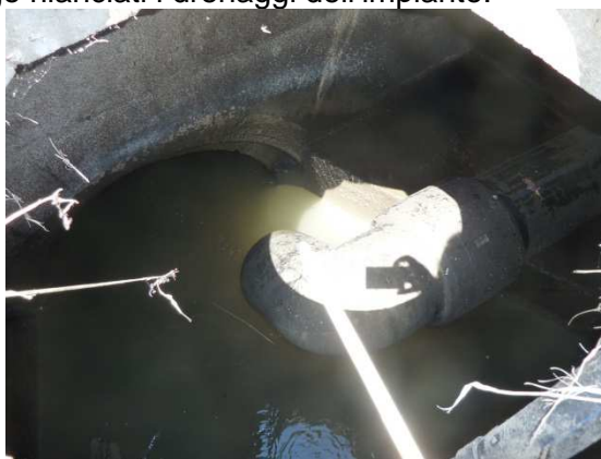
Figura 2 – Tubazioni drenaggi in arrivo al pozzetto 1
