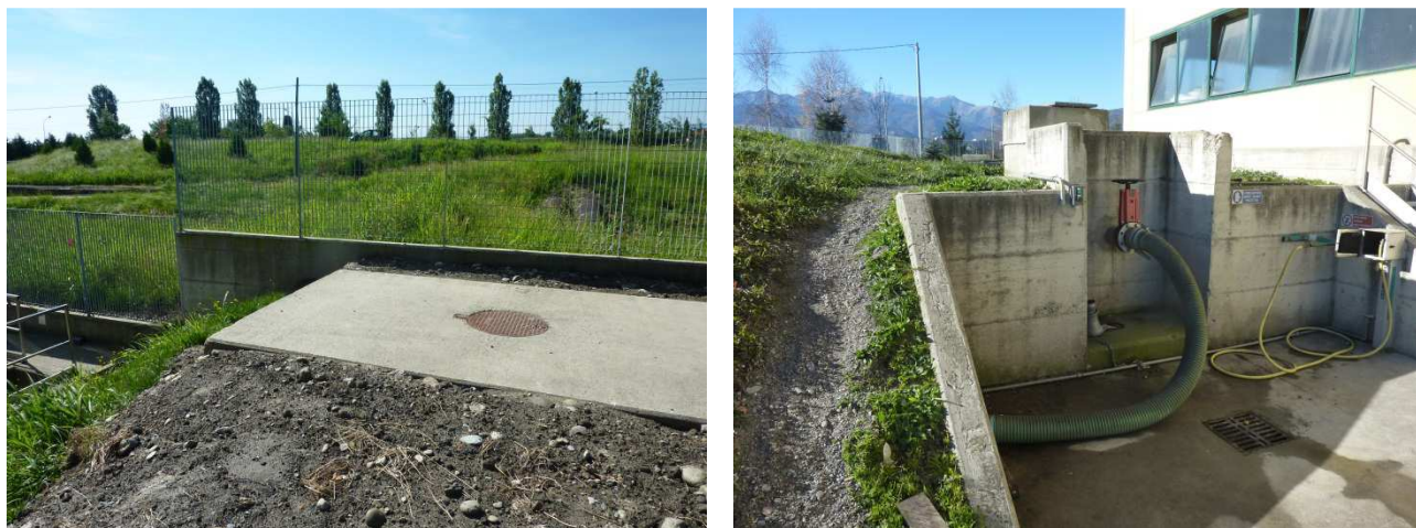
Figura 1 – Pozzetto 1 (a sx), pozzetto 2 e attacco per autospurgo (a dx)
