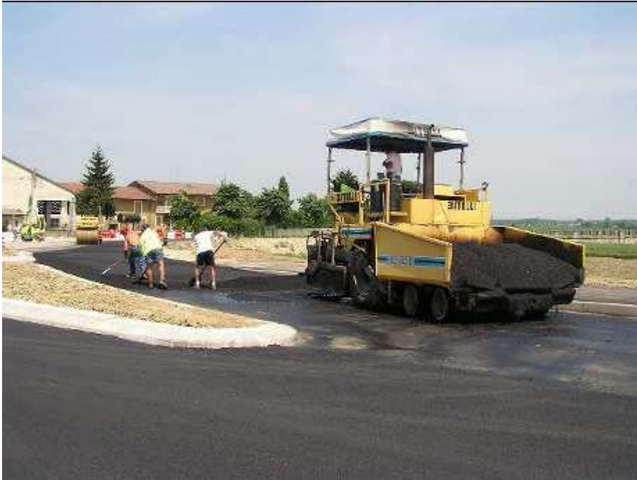
Stesa asfalto con vibrofinitrice.
