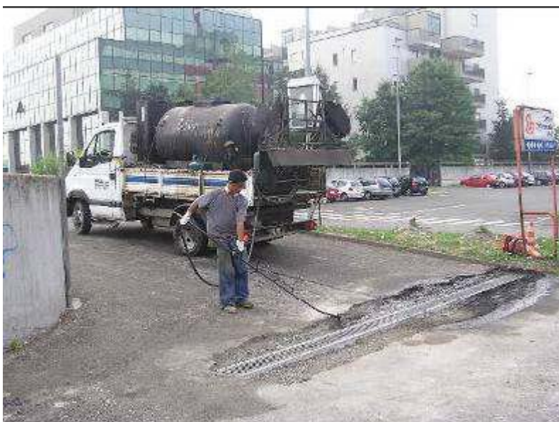
Applicazione emulsione bituminosa manuale.
